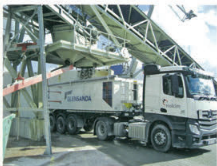
UMSTELLUNG des Verschleißschutzes der Lkw-Beladung in einem Splittwerk.
