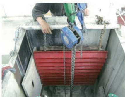
ANDERSHERUM DENKEN – und einbauen. Pucest-Stufenprallplatte „upside down“, das heißt, die Öffnungen zeigen nach unten.
